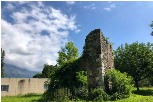
Ruine de ferme agricole – Crédit K. Bacher
